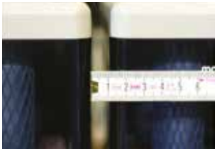
Abb. 5-13: 10 mm Abstand zwischen den Batteriezellen
