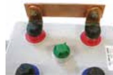
Abb. 5-18: 2 Montage der Endpole (Anschlussplatten)
